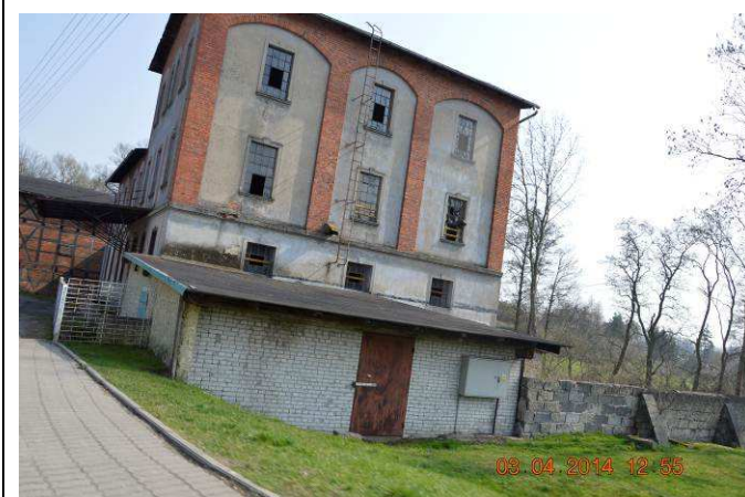
Fot. 11 Teren objęty opracowaniem
