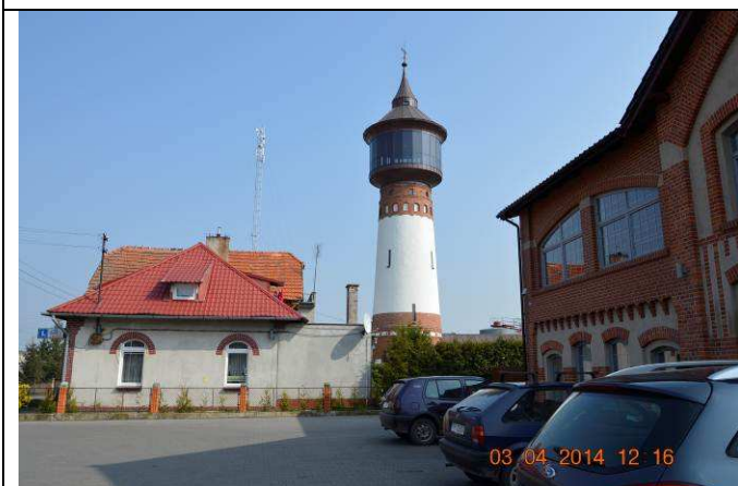
Fot. 5 Teren objęty opracowaniem
