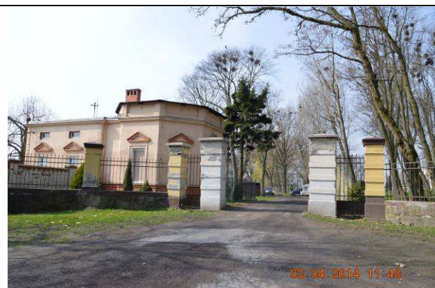
Fot. 8 Teren objęty opracowaniem
