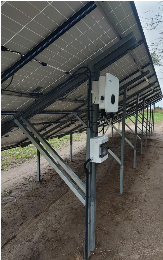
Fot. Umieszczenie inwertera na konstrukcji. Źródło: archiwum firmy Energozysk.
