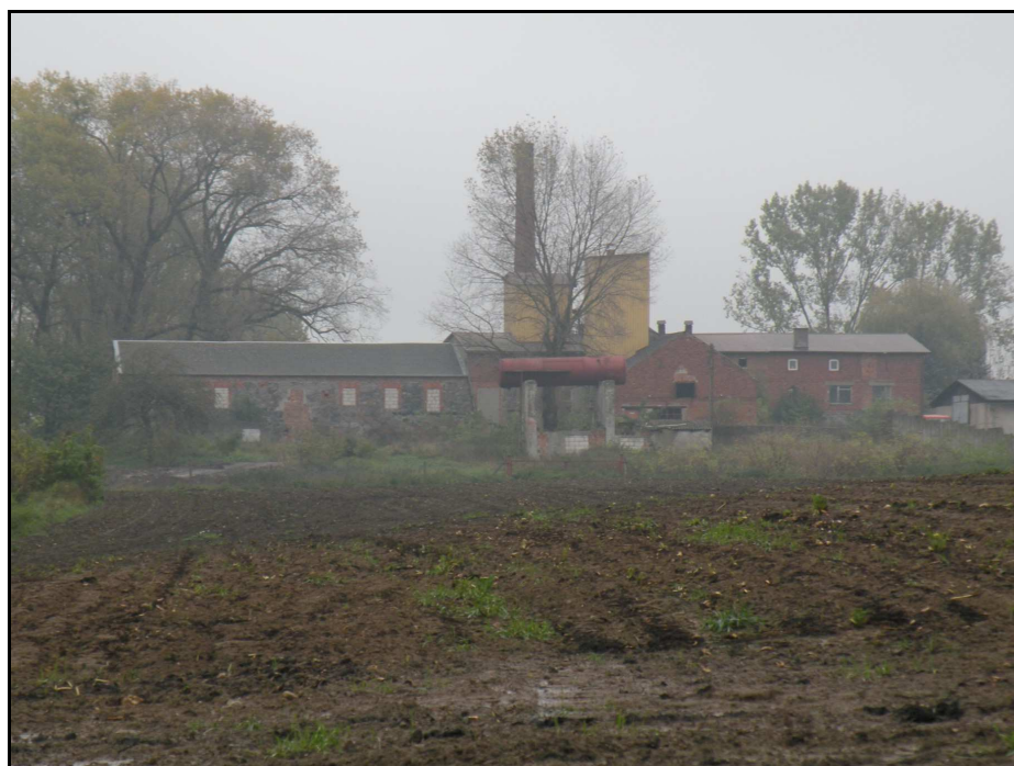
Fot.6. Obiekt gorzelnii w zespole dworsko-folwarcznym, objęty ochroną konserwatorską w granicach wyznaczonego terenu zabudowy mieszkaniowej wielorodzinnej z usługami MWu2 - widok od strony zachodniej.
