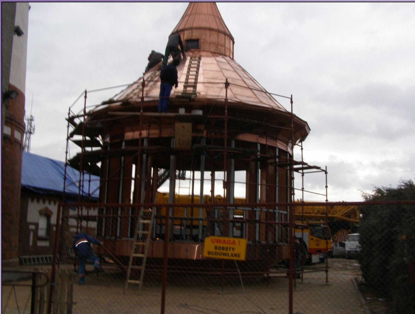
Fot. 29 Nowa głowica wieży ciśnień (29.12.2011 r.)
