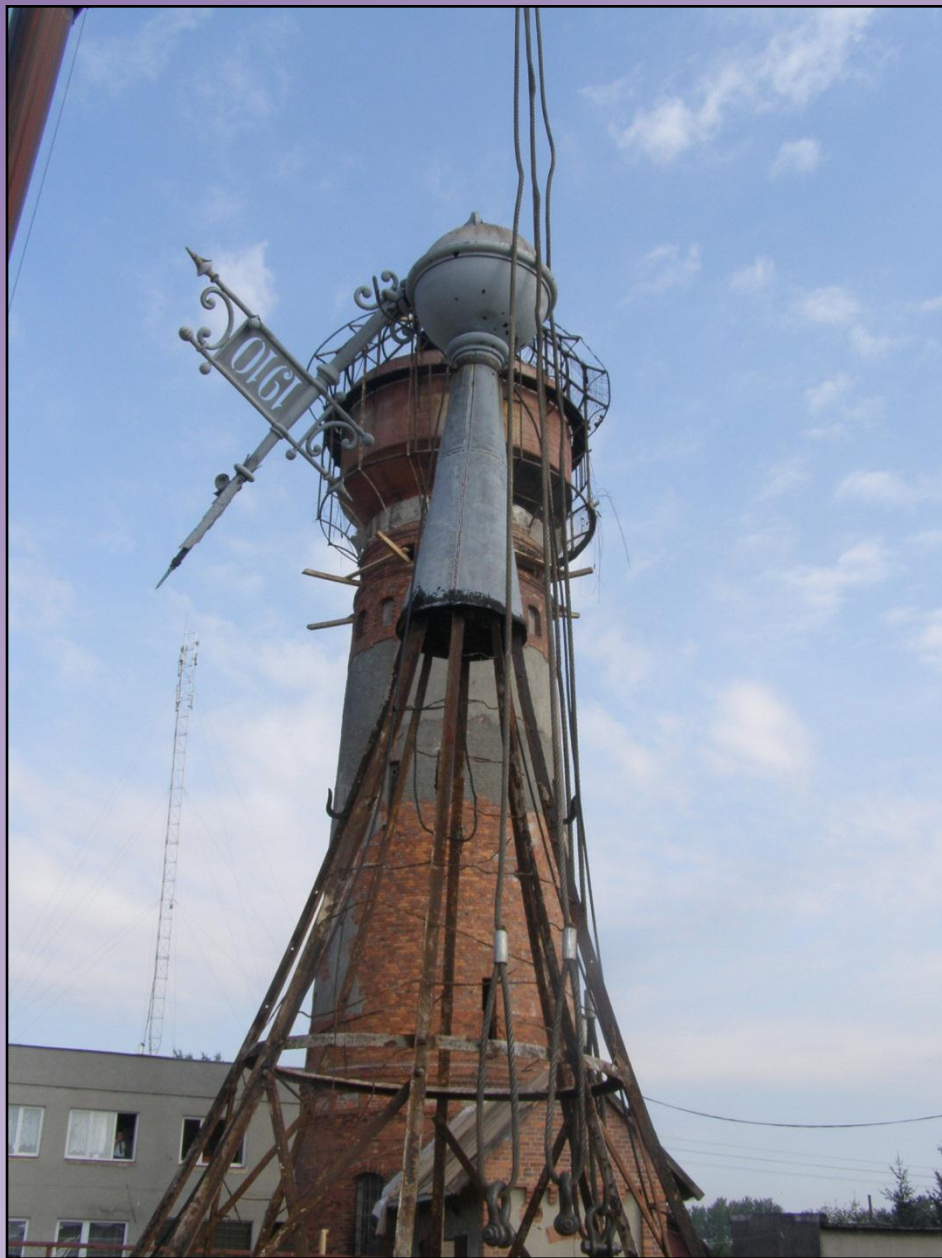
Fot. 17 Zdjęta iglica wieży ciśnień (22.08.2011 r.)
