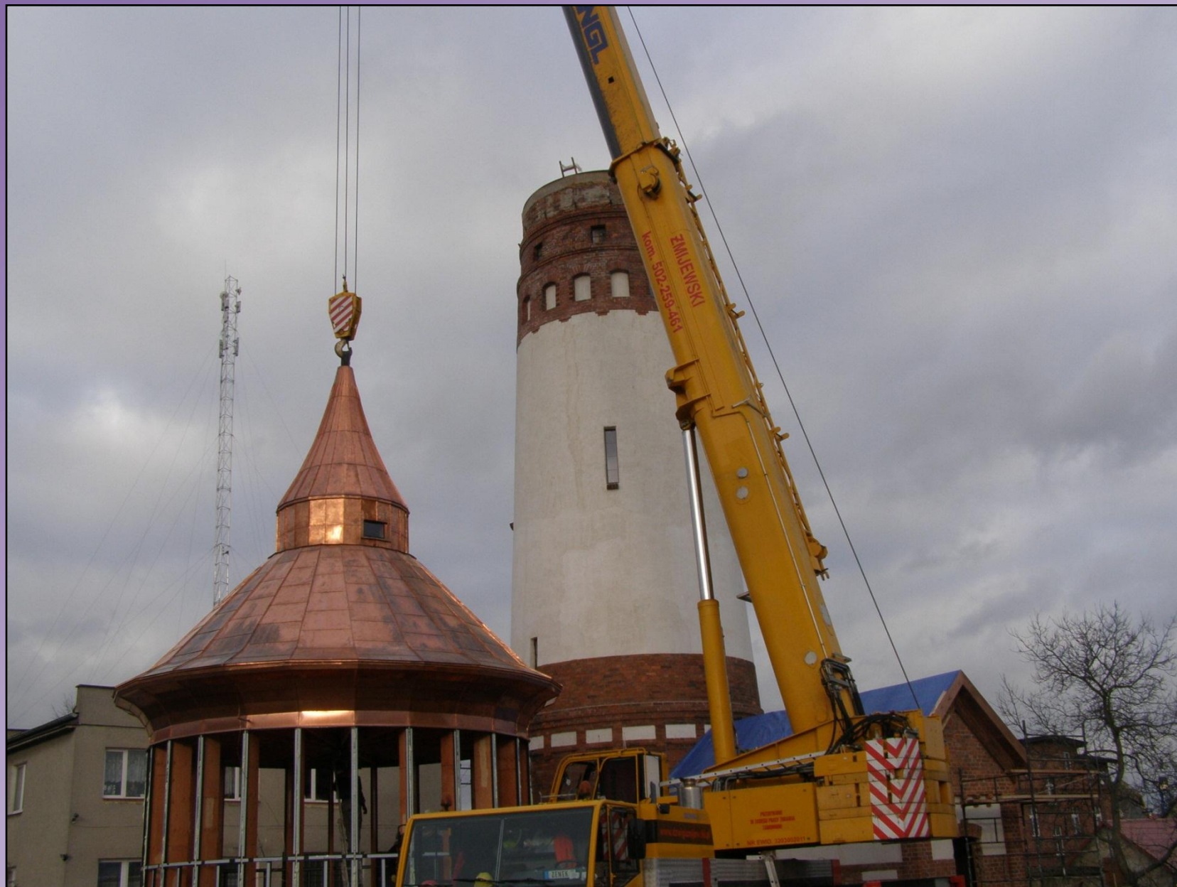
Fot. 30 Początek prac montażowych (29.12.2011 r.)
