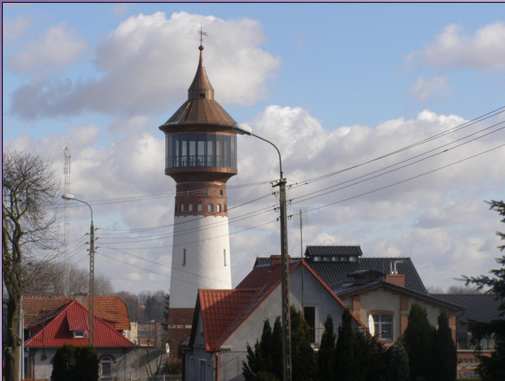
Fot. 49 Wieża ciśień w Łobzenicy (27.02.2012 r.)
