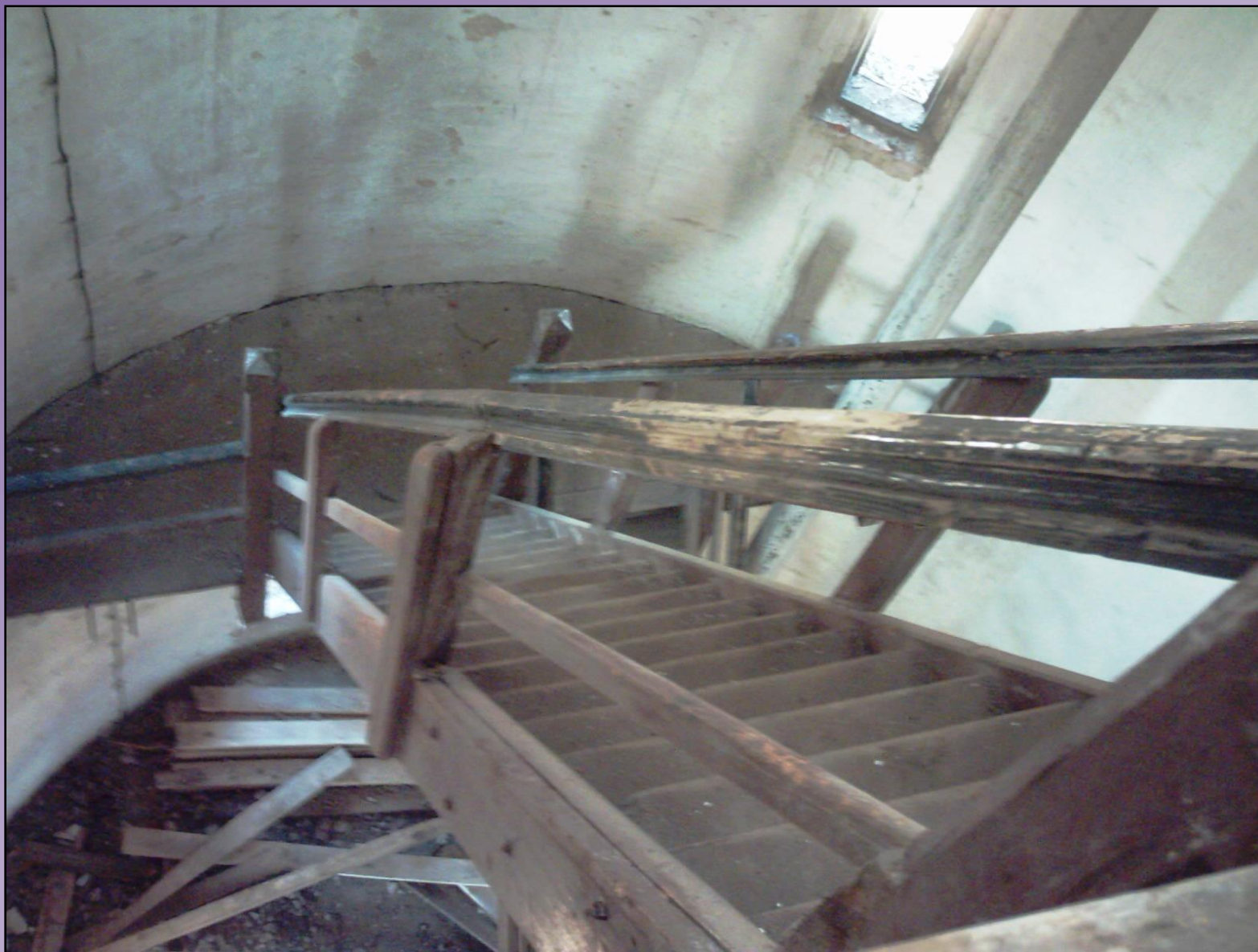
Fot. 24 Schody wieży ciśnięć (22.08.2011 r.) Autor: Piotr Orzeł
