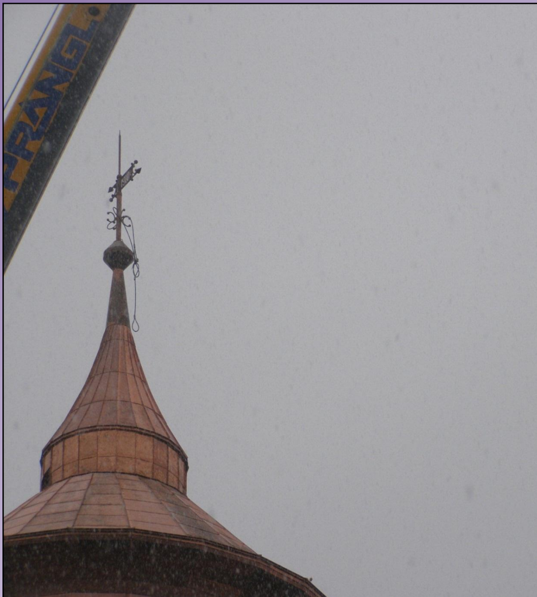
Fot. 38 Wieża ciśnień z nową iglicą (30.12.2011 r.)
