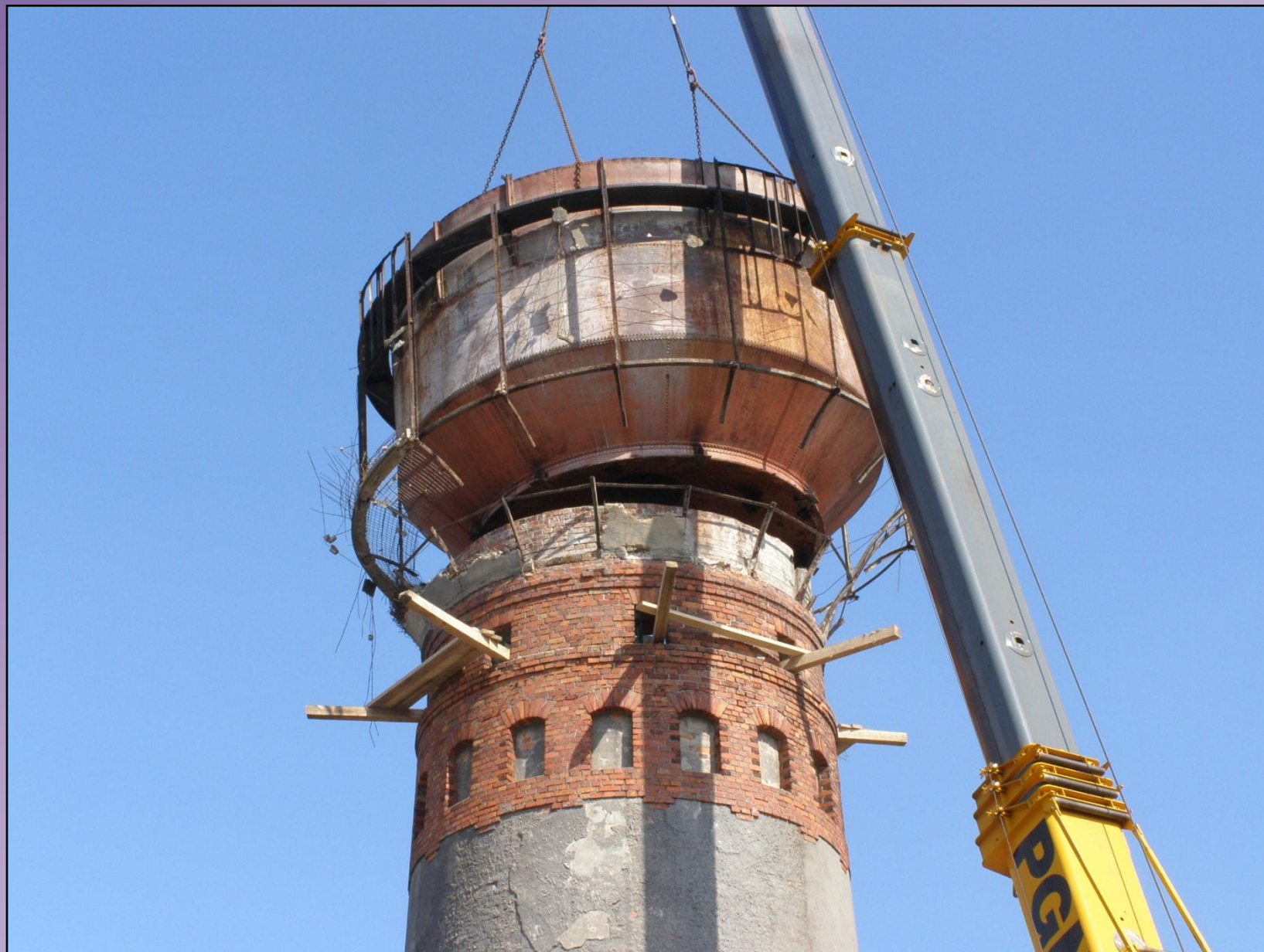
Fot. 19 Rozpoczęcie demontażu zbiornika wodnego (22.08.2011 r.)
