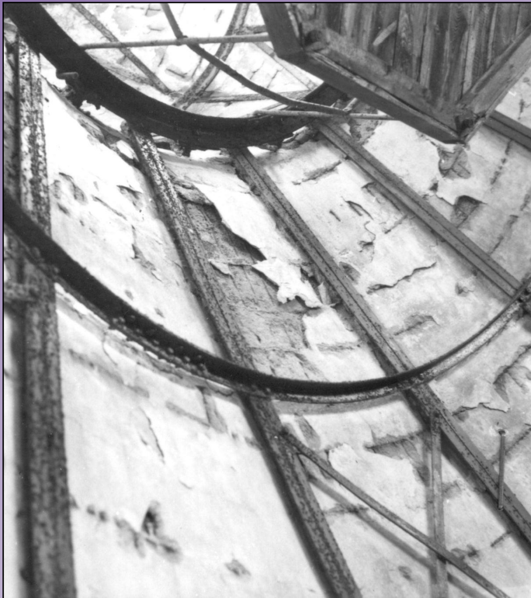
Fot. 11 Widok od dołu konstrukcji wieży oraz zawieszzonego pomostu drewnianego na poziomie 26,3 m.
