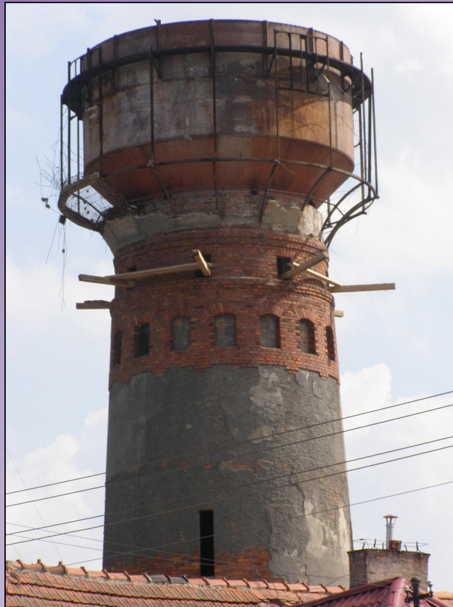
Fot. 18 Wieża ciśnień jeszcze ze zbiornikiem wodnym (22.08.2011 r.)
