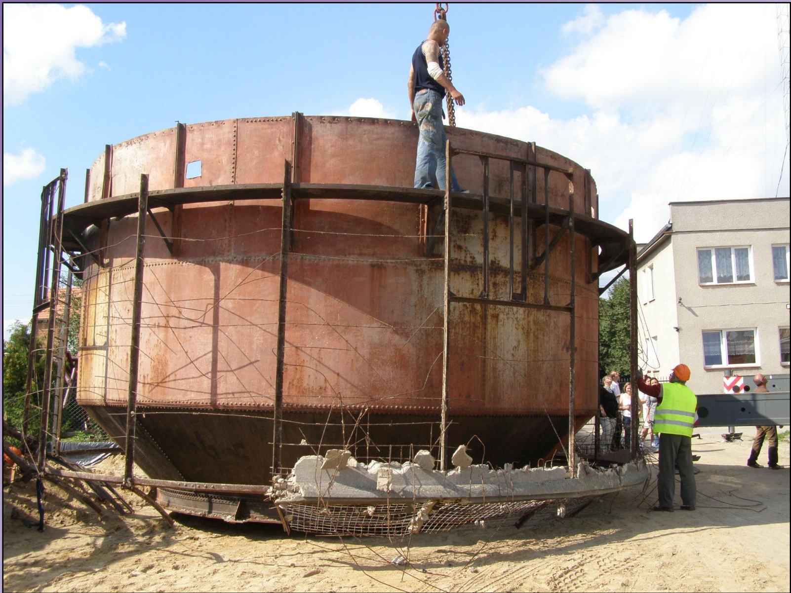
Fot. 21 Zdemontowany zbiornik wodny (22.08.2011 r.)
