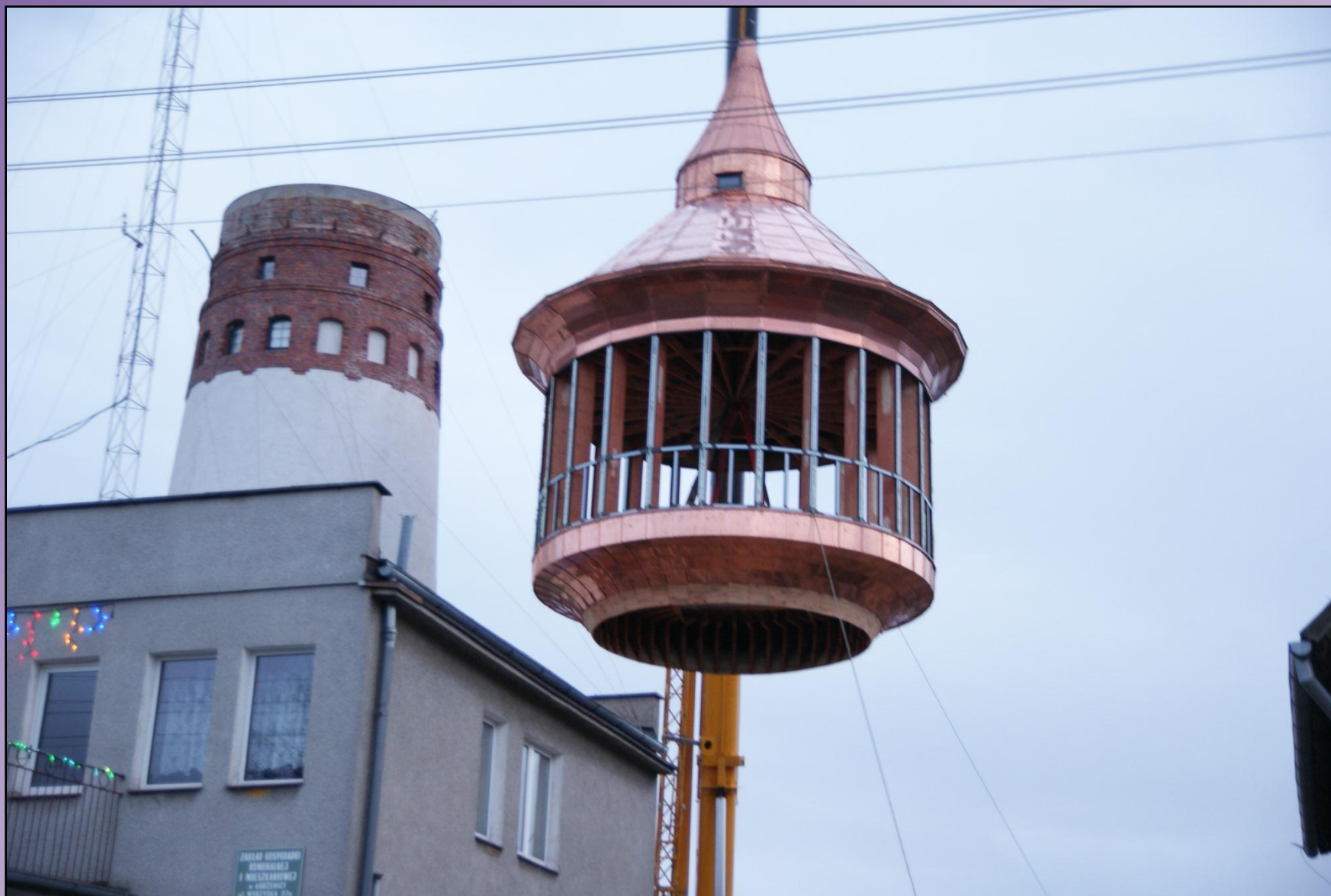
Fot. 31 Ciąg dalszy prac związanych z instalacją głowicy wieży ciśnień (29.12.2011 r.) Autor: Jan Dubiela
