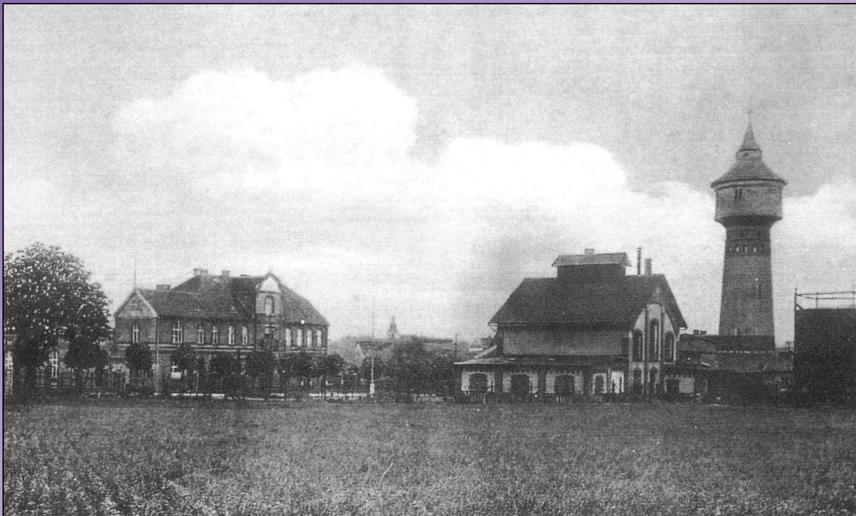
Fot. 1 Widok na wieżę ciśnień w Łobzenicy, gazownię i budynek Banku Ludowego. Fotografia około 1912 r. Źródło: Łobzenica na starej fotografii, 1998
