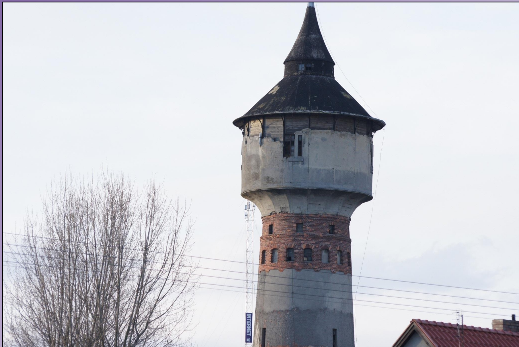
Fot. 14 Górna część wieży ciśnień (04.03.2010 r.)
