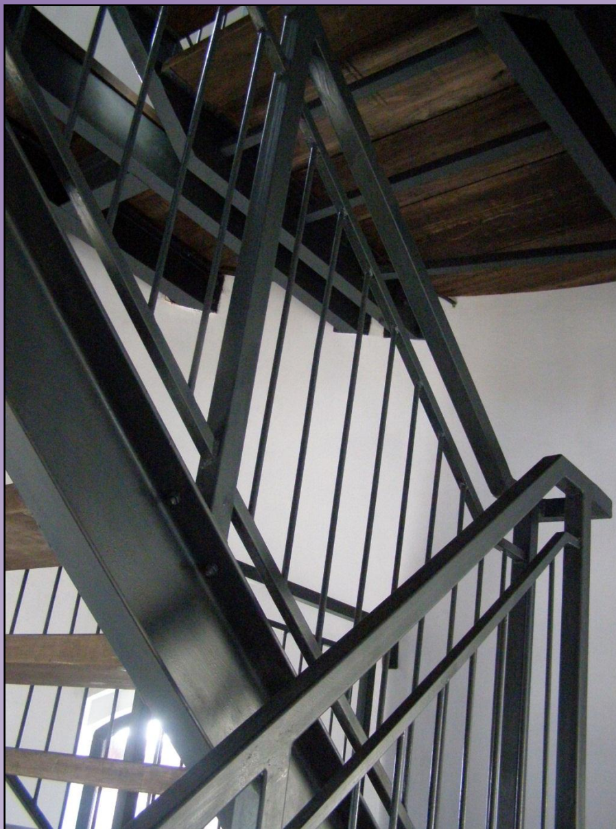
Fot. 42 Klatka schodowa wieży ciśnień (16.03.2012 r.) Autor: Jerzy Cynajek
