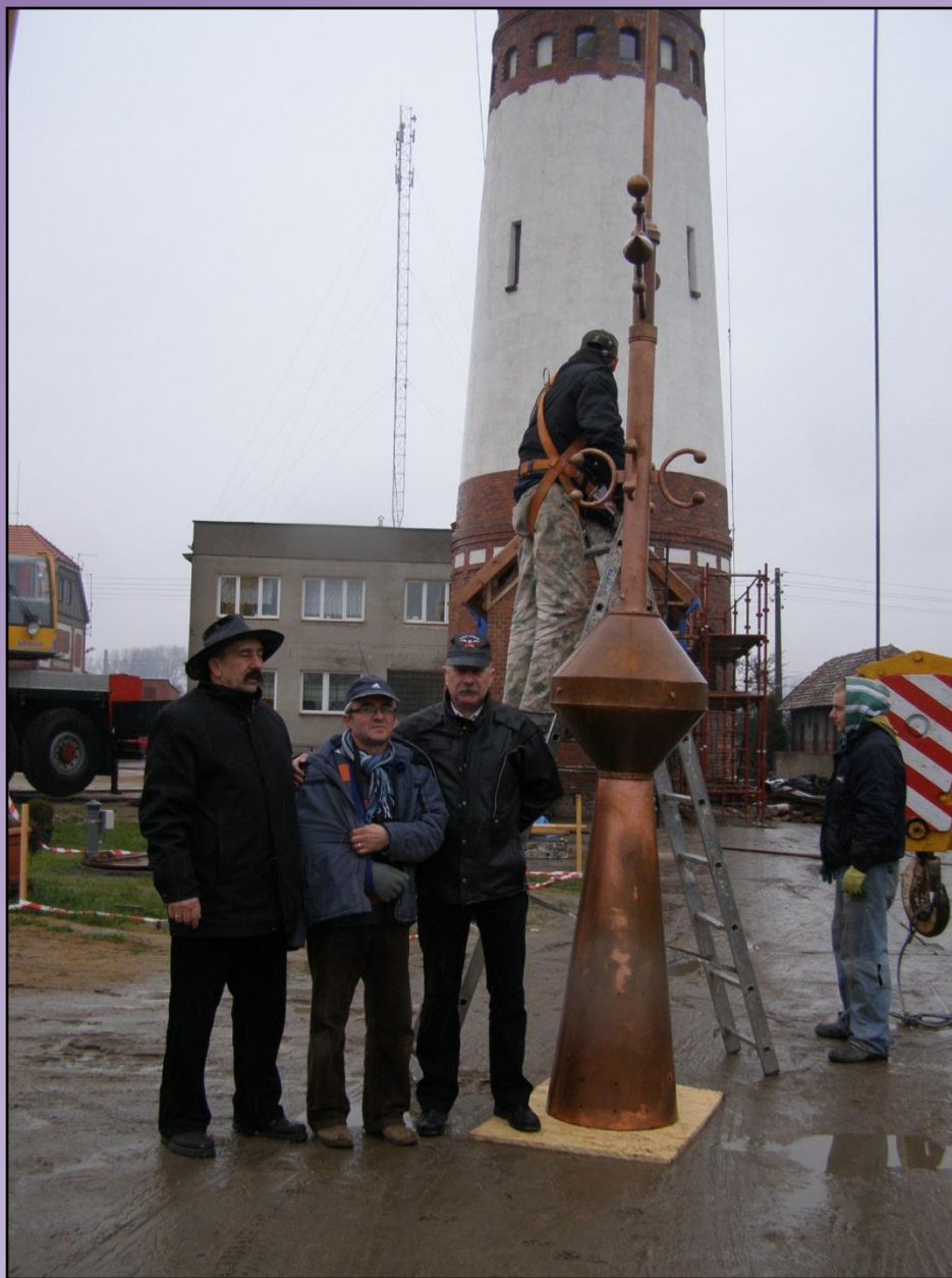
Fot. 36 Wykonawca rewitalizacji wieży ciśnień przy nowej iglicy (30.12.2011 r.) Autor: Jerzy Cynajek
