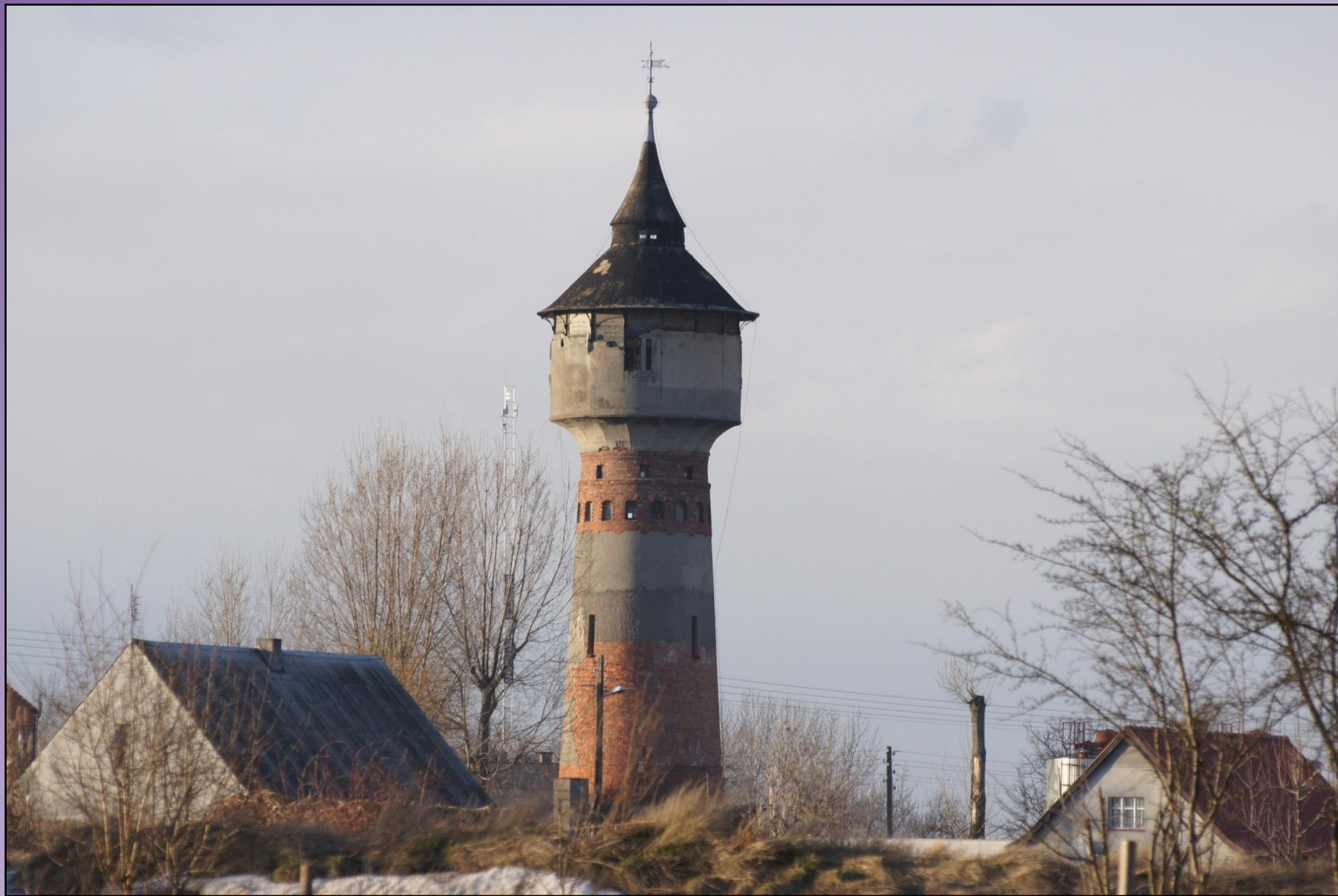
Fot. 13 Widok ogólny wieży ciśnień (04.03.2010 r.)
