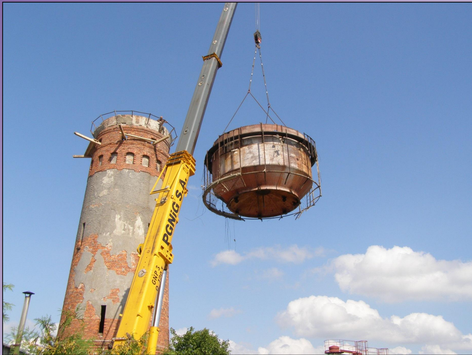
Fot. 20 Prace nad demontażem zbiornika wodnego (22.08.2011 r.)
