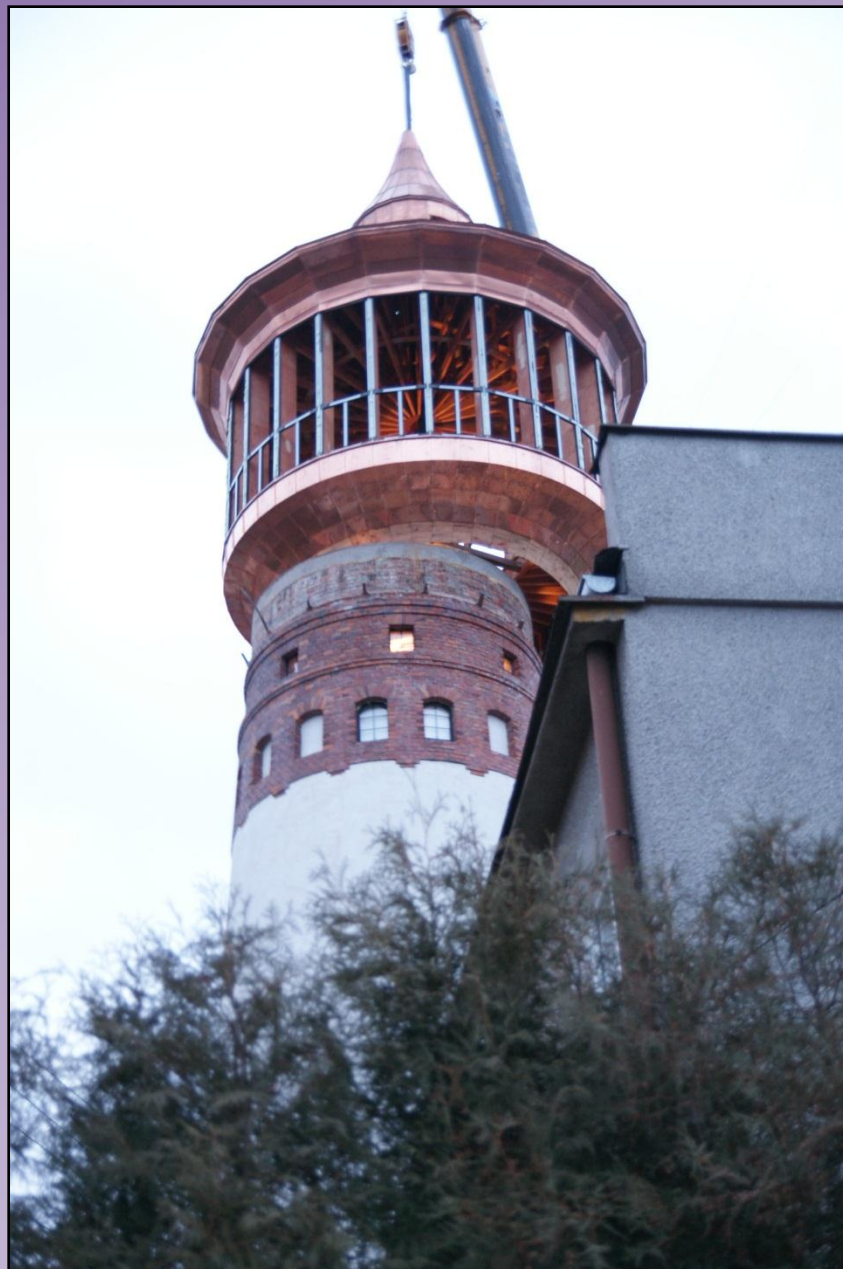
Fot. 32 Prace nad montażem głowicy (29.12.2011 r.)
