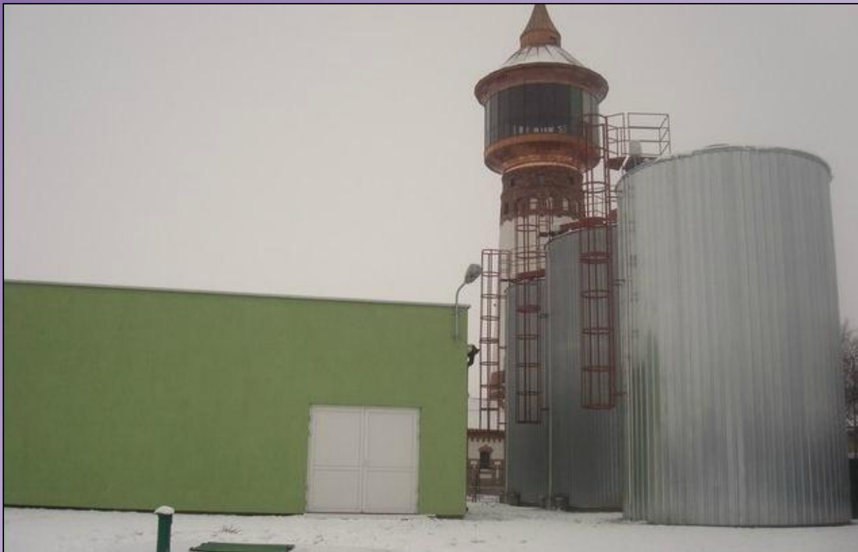
Fot. 47 Hydrofornia w Łobżenicy wraz z wieżą ciśnień Źródło: Internet, 2012g
