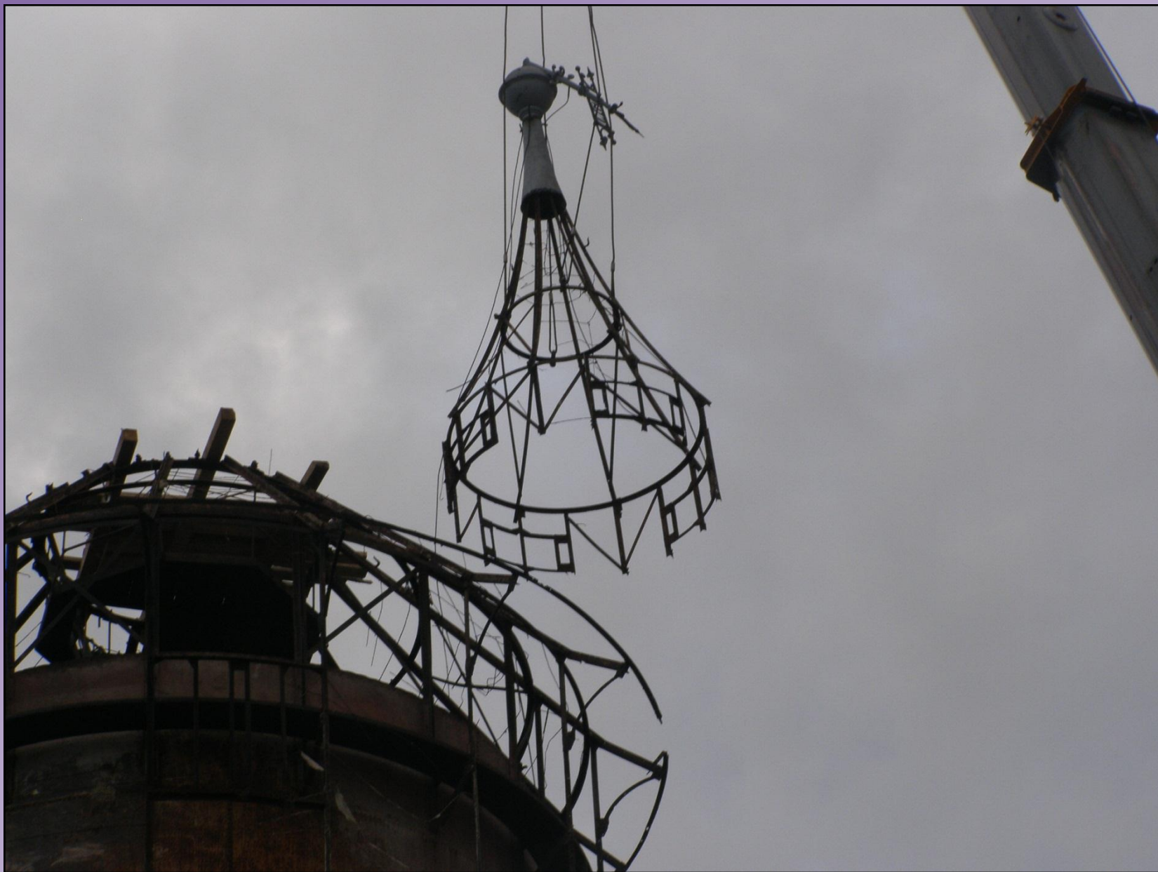
Fot. 16 Rozpoczęcie demontażu zakończenia wieży ciśnień (22.08.2011 r.) Autor: Jerzy Cynajek
