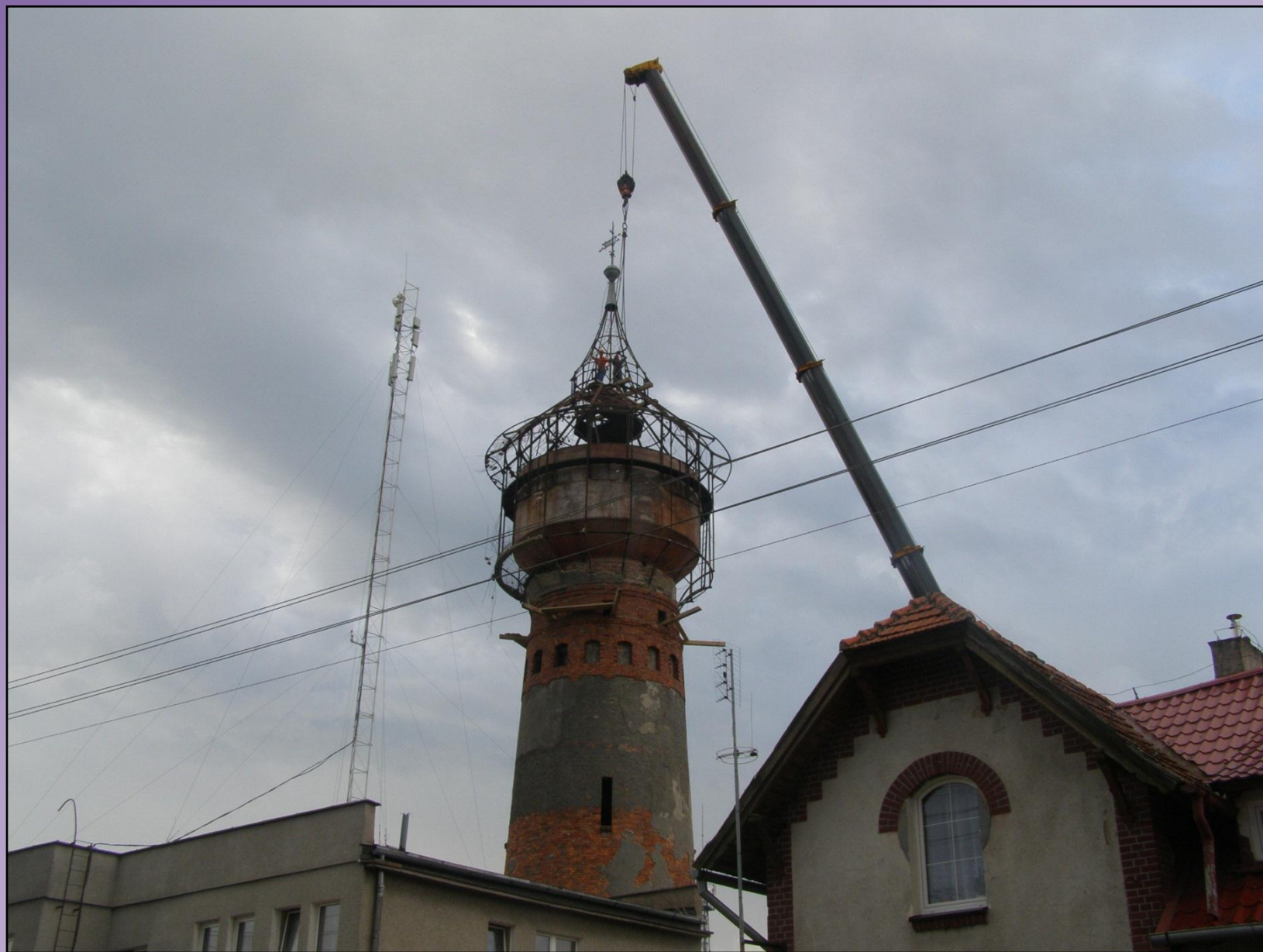
Fot. 15 Przygotowania do demontażu wieży ciśnień (22.08.2011 r.)
