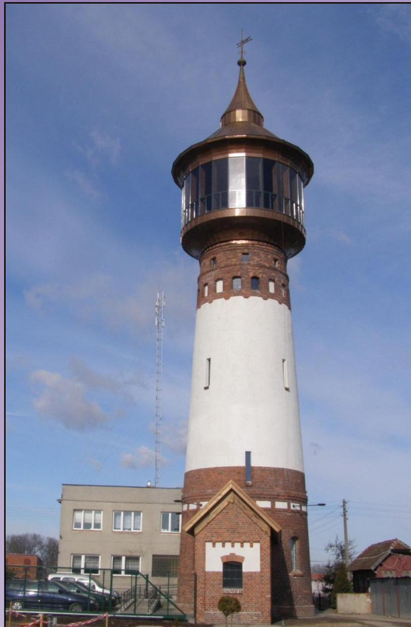
Fot. 39 Wieża ciśnień w Łobżenicy wraz z budynkiem dawnej przepompowni (27.02.2012 r.) Autor: Jerzy Cynajek
