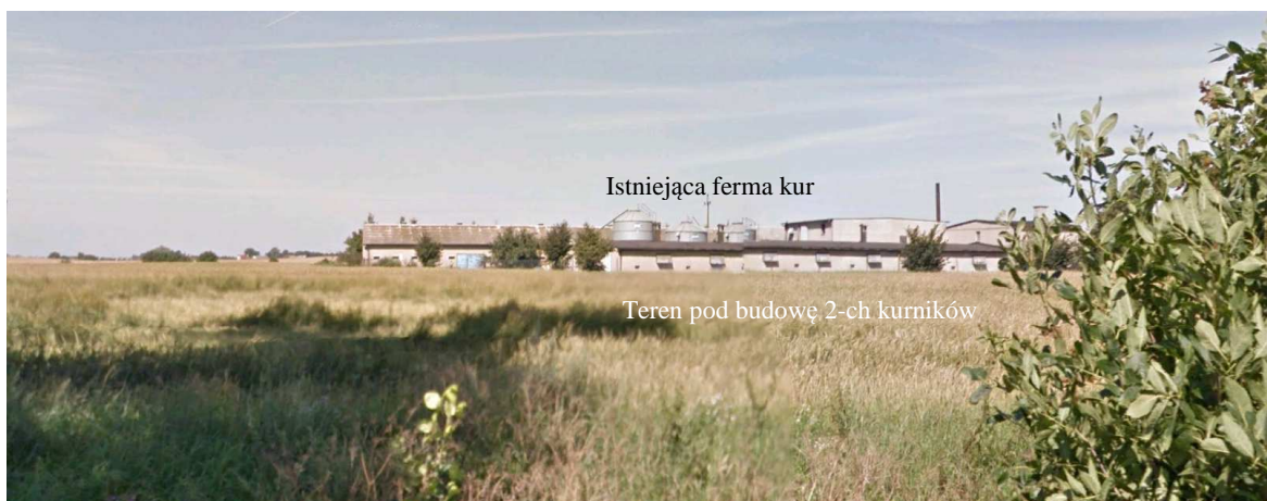
Widok z drogi będącej przedłużeniem ul. Złotowskiej w Łobżenicy
